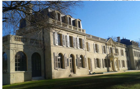
façade côté parc
