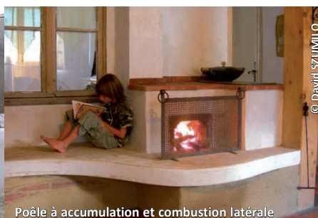
Poêle à accumulation et combustion latérale
