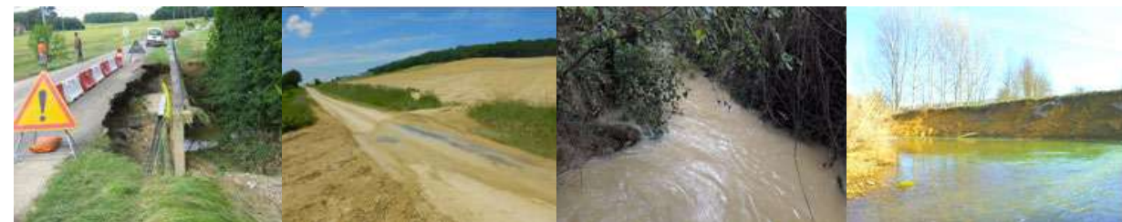
Dégâts sur les ouvrages
